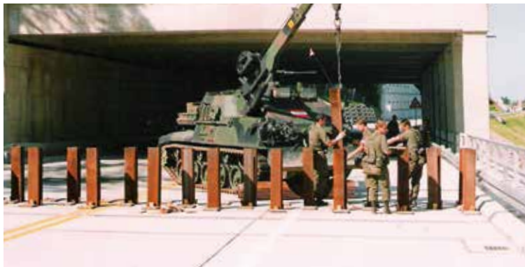
◀ Aktivierung von Stecksperrn vor dem Karawankentunnel.
