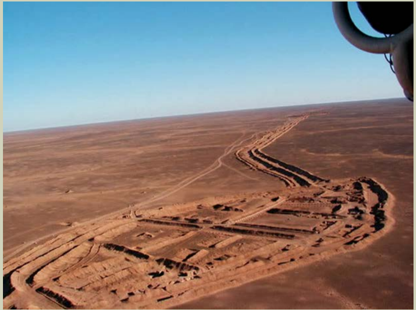
Marokko legte zur Abwehr der Polisario in den 1980er Jahren einen gut 2.500 km langen, mehrreihigen Sand- und Steinwall (berm) mit zahlreichen Überwachungs- und Sicherungsanlagen an.
