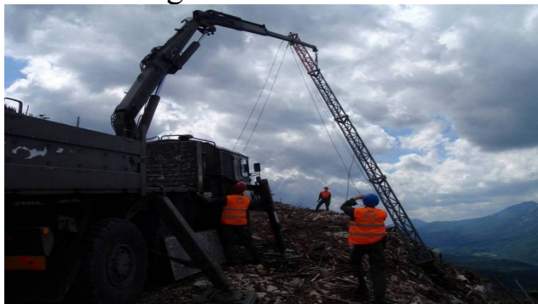
Aufstellen einer Stütze der Seilbahn
