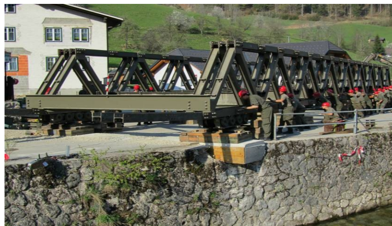
Die D-Brücke wird vorgeschoben
