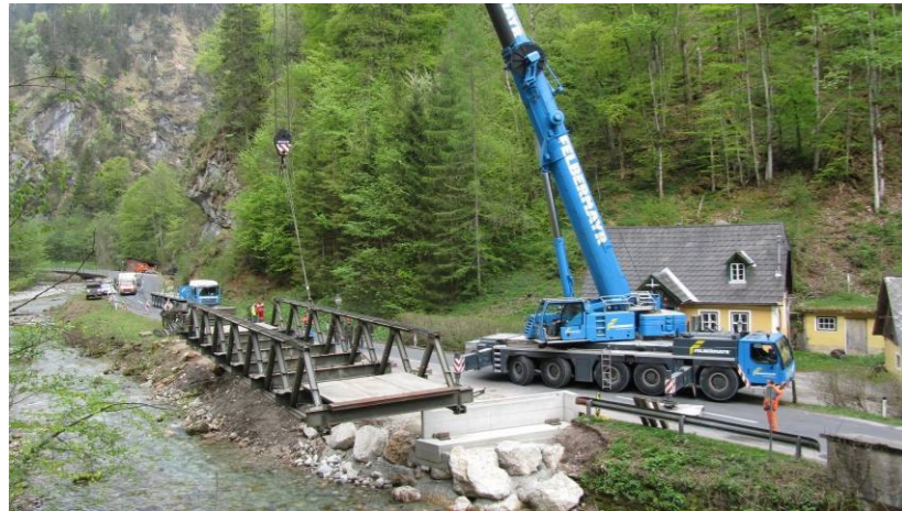
Mit einem zivilen 200mt Kran wird die Brücke angehoben
