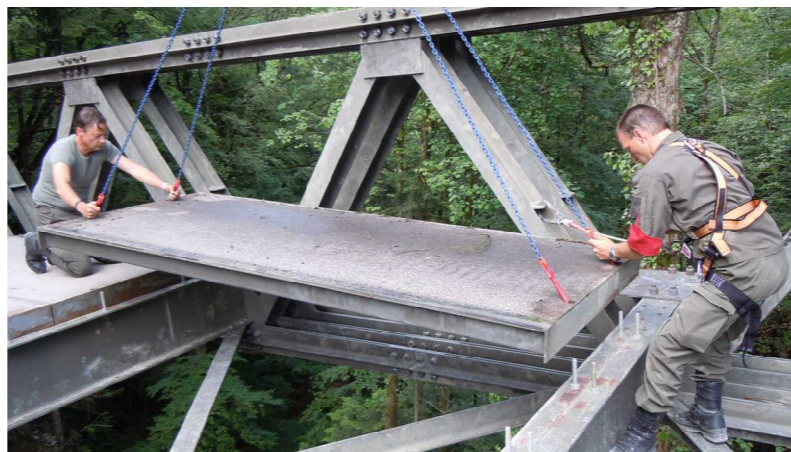
Die Fahrbahnplatten werden eingehoben
