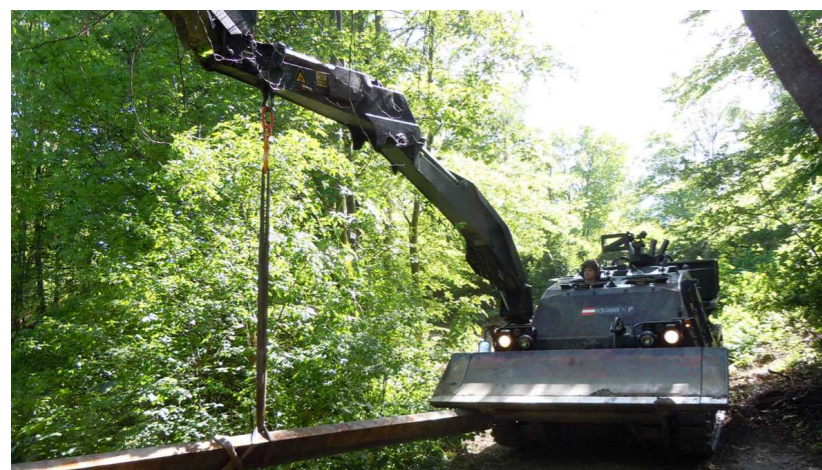
Mit dem PiPz wurden die I-Träger aus- und wieder eingehoben
