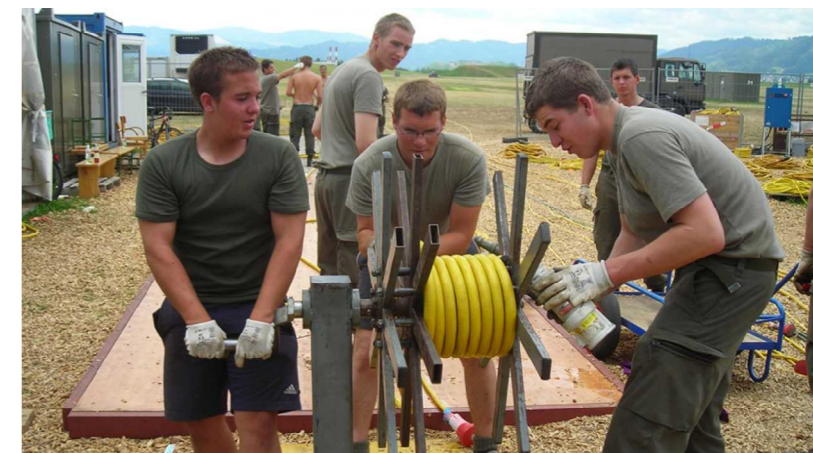
Beim Abbau mussten ca. 16 km Kabel ausgegraben, sortiert, gereinigt und gewickelt werden
