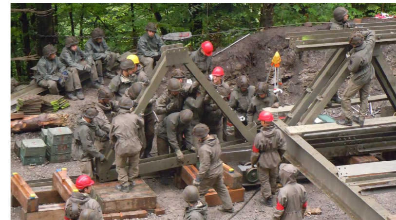
Ein Hauptträger der D-Brücke wird angebaut. Hier war aufgrund des Platzmangels eine Unterstützung durch sPiMasch nicht möglich.
