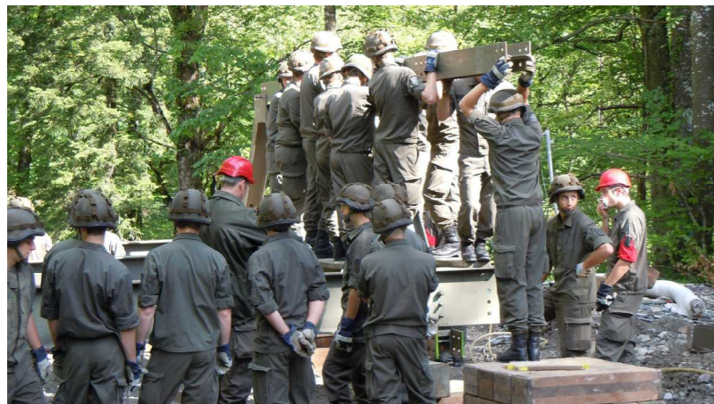
Die Rekruten des ET 4/11 beim Zusammenbau der D-Brücke
