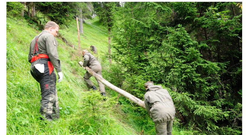
Bei einem Gewicht von 25-40kg je Pfahl ist das Verbringen im steilen Gelände äußerst mühsam.
