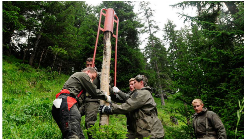
Die „manuelle“ Pfahlsetzgruppe beim Rammen eines Zaunpfahles. Aufgrund der Länge der Pfähle ein sehr schwieriges Unterfangen.
