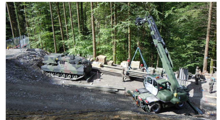
Der Bau wurde durch den neuen Teleskopklader „Manitou“ sowie den Bergepanzer Greif zur Sicherung unterstützt
