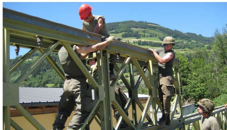
Die Rekruten des ET 4/11 beim Abbau der Bailey-Brücke.
