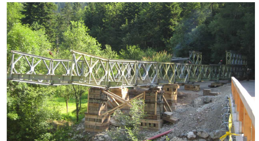
Die Hilfsstapel beim Abbau der Bailey-Brücke in Scheffau erreichten eine notwendige Höhe von bis zu 3,1m.
