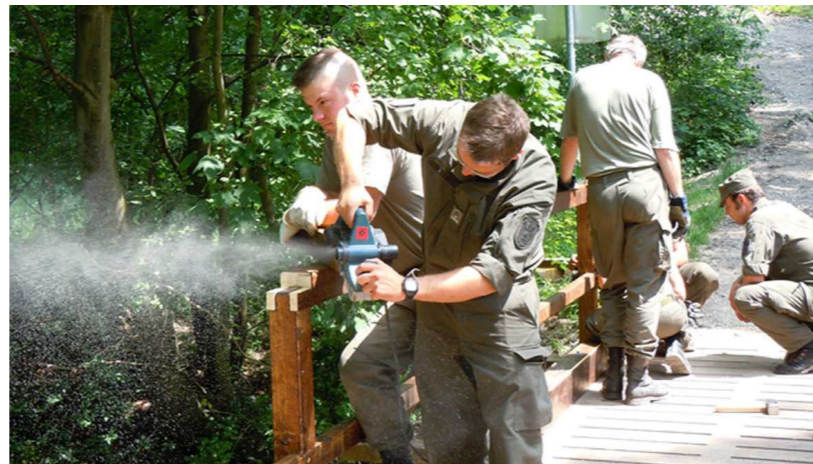
Eine der letzten Arbeiten bildete die Anbringung des Handlaufs
