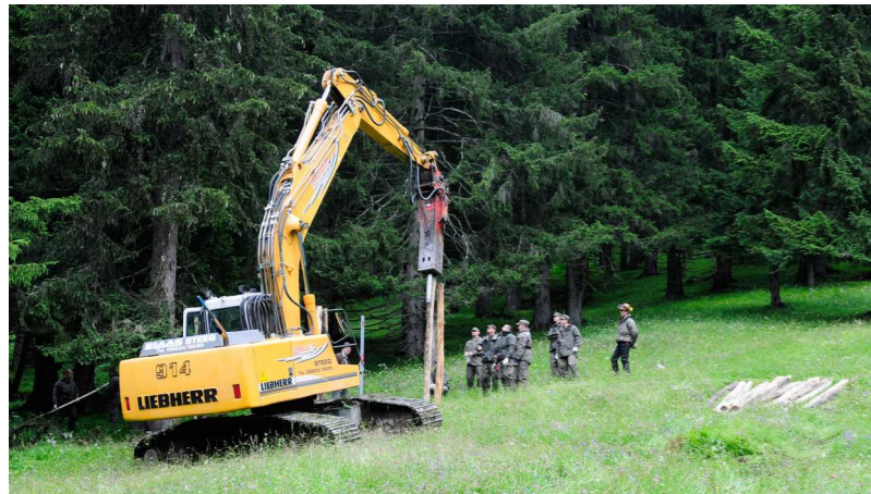
Der „maschinelle“ Pfahlsetztrupp beim Einschlagen der Pfähle für das Wildgatter im Raum Lechtal
