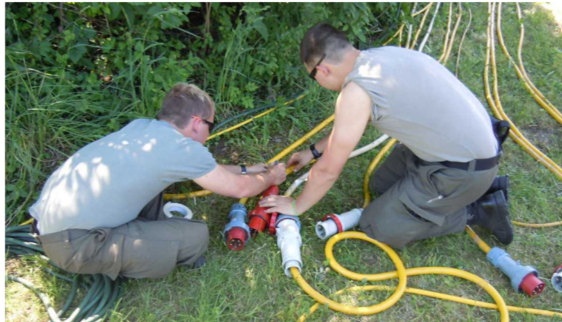
5500 m Kabel wurden zur Stromversorgung im Camp verlegt
