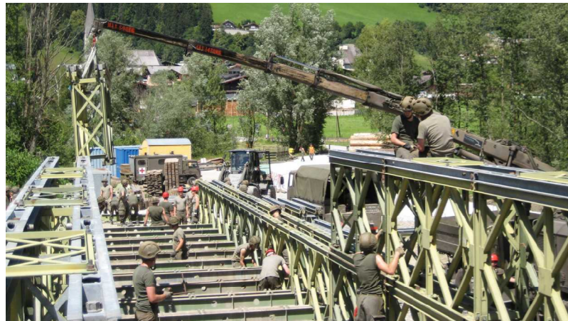
Mit Unterstützung durch den Kran des sLKW erfolgte der Ausbau.
