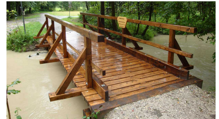
Die fertig gestellte Behelfsbrücke über dem Mühlbach
