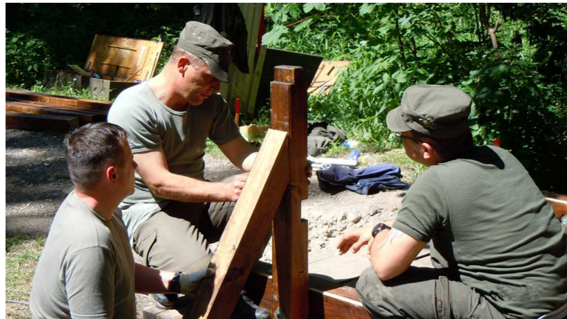
Die Geländersteher der neuen Brücke werden montiert
