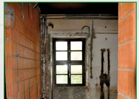
Blick in den neuen Küchenbereich
