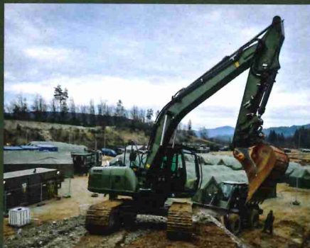
Baupioniere stellen durch den Feldlagerbau die Infrastruktur für die Truppe sicher
