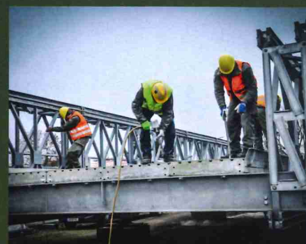
Der Bau von Behelfs- und Ersatzbrücken sind klassische Aufgaben
