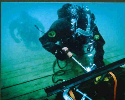
Ein Taucher beim Unterwasserschweißen
