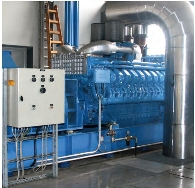
Notstromversorgung eines Unternehmens, Vier MAN-Dieselmotoren werden bei Stromausfall mit Druckluft gestartet und können die wichtigsten Bereiche mit Strom versorgen
