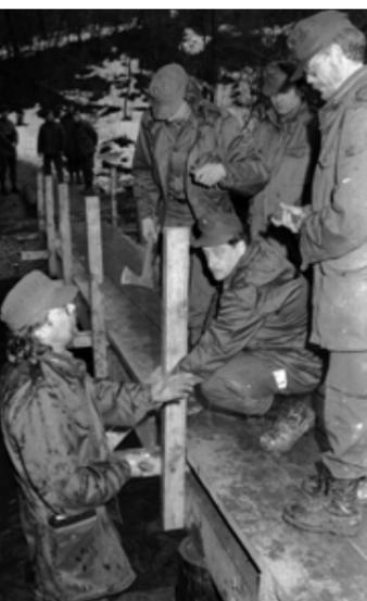
Die Pioniere des Landwehrstammregimentes 21 errichten in Mauerbach für die Bevölkerung eine Behelfsbrücke. Die Hilfeleistung erfolgte im Rahmen der Ausbildung. Die Fußgängerbrücke erleichterte den Anrainern den Zugang zu ihren Grundstücken.
