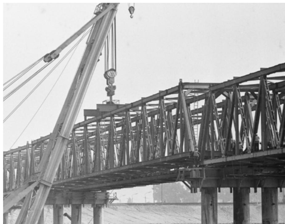
Pionierkräfte errichteten eine Ersatzbrücke. Sie diente während der Bauzeit der neuen Reichsbrücke zur Aufrechterhaltung des Schienen- und Straßenverkehrs und wurde allen Erfordernissen gerecht.
