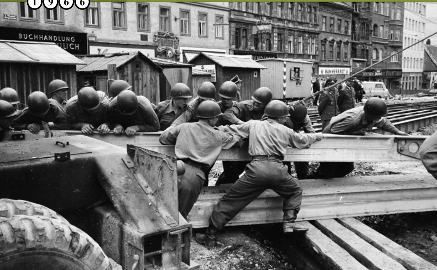
Brückenbau im Zuge der Errichtung der USTRABA (unterirdische Straßenbahn). Unter der Leitung des Kommandanten der Pioniertruppschule, Oberst Karl Cerny, errichteten Pioniere eine Hilfsbrücke, um den Verkehr im Baustellenbereich auf dem Gürtel möglichst wenig zu behindern.
