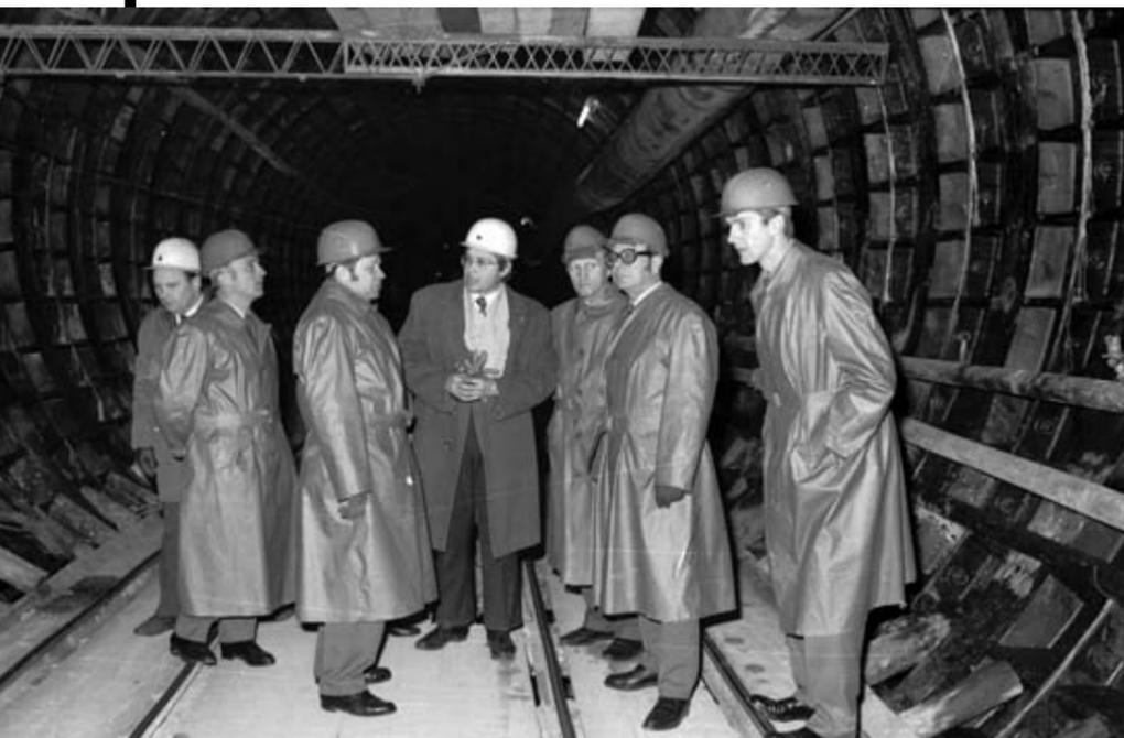
Offiziere des Militärkommandos Wien besichtigen die U-Bahnbaustelle der U1 im Stollen vom Karlsplatz zum Reumannplatz. Der Bau der Tunnelröhre erfolgte in geschlossener Bauweise mittels Schildmaschine, dem sogenannten „Wiener Maulwurf“. Gesichert wurde das Tunnelprofil mit Stahlstützen. Es war das aufwendigste kommunale Bauprojekt seit dem Wiederaufbau nach dem 2. Weltkrieg.
