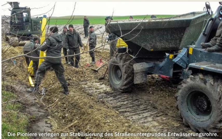
Die Pioniere verlegen zur Stabilisierung des Straßenuntergrundes Entwässerungsrohre.
