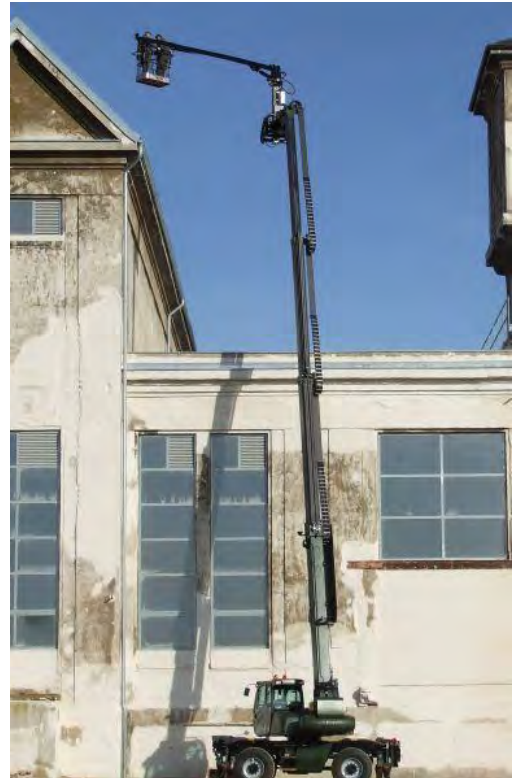
Abb. 43: Teleskoplader Manitou MRT 2150 mit 30m-Arbeitskorb
