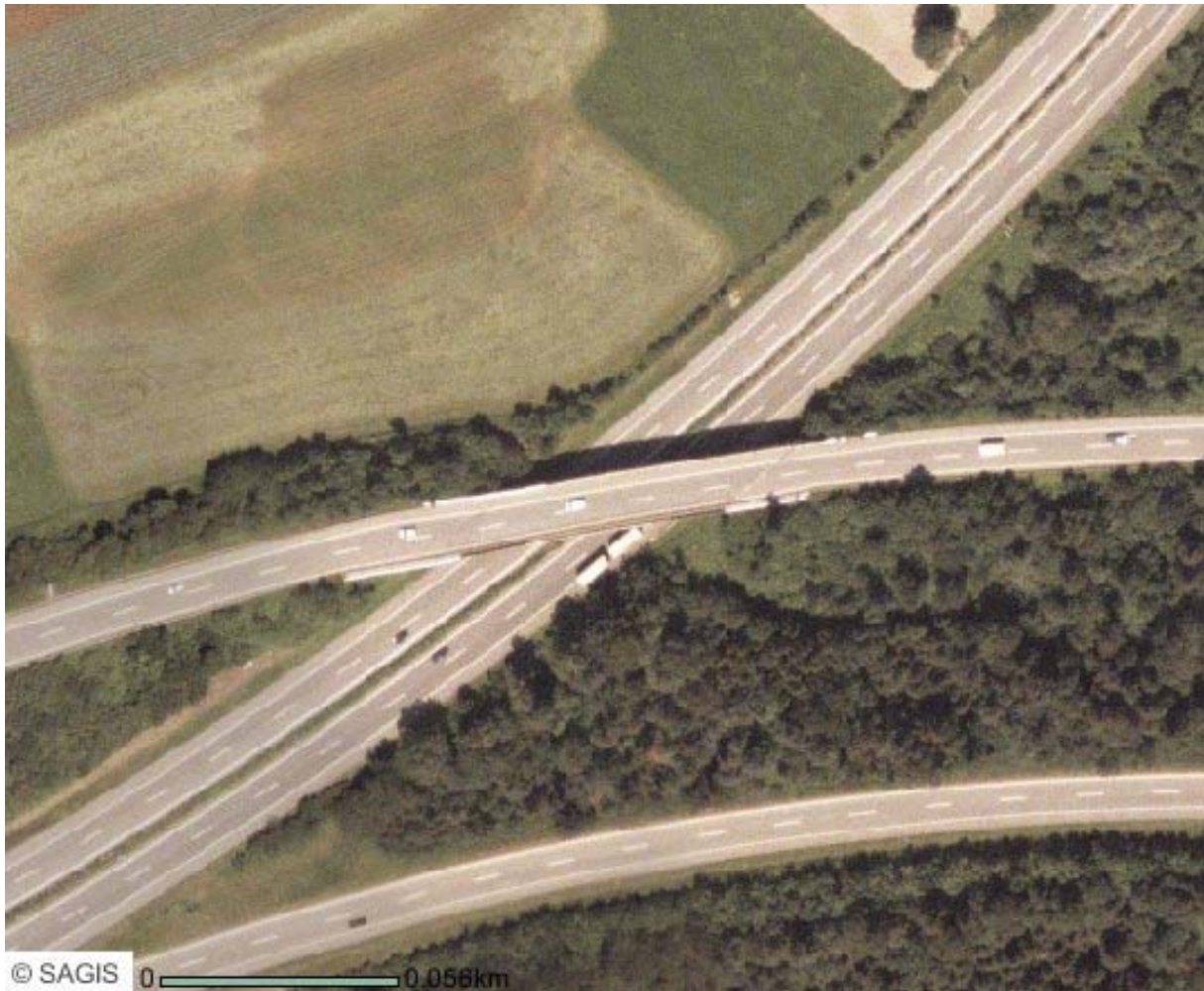
Abbildung 37: Autobahnknoten A1/A10 zwischen Grenzübergang und Salzburg 88
