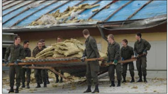
Das Dach der Weinkellerei Lenz Moser wurde abgedeckt
