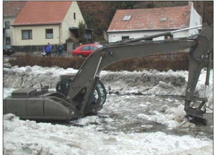
OSTv Wilfert mit „seinem“ Bagger in den eisigen Fluten der Krems.
