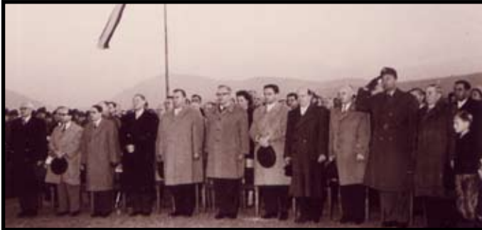
Verteidigungsminister Ferdinand Graf wohnte mit vielen Fest- und Ehrengästen der Grundsteinlegung für die neue Kaserne bei.
