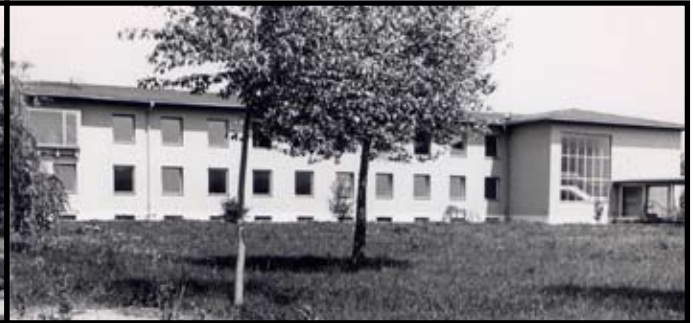
Der 1. Stock war ausschließlich dem Brigadekommando gewidmet. Das Erdgeschoss wurde mit 01.01.1963 zum Hauptquartier des neu aufgestellten Panzerstabsbataillon 3.
