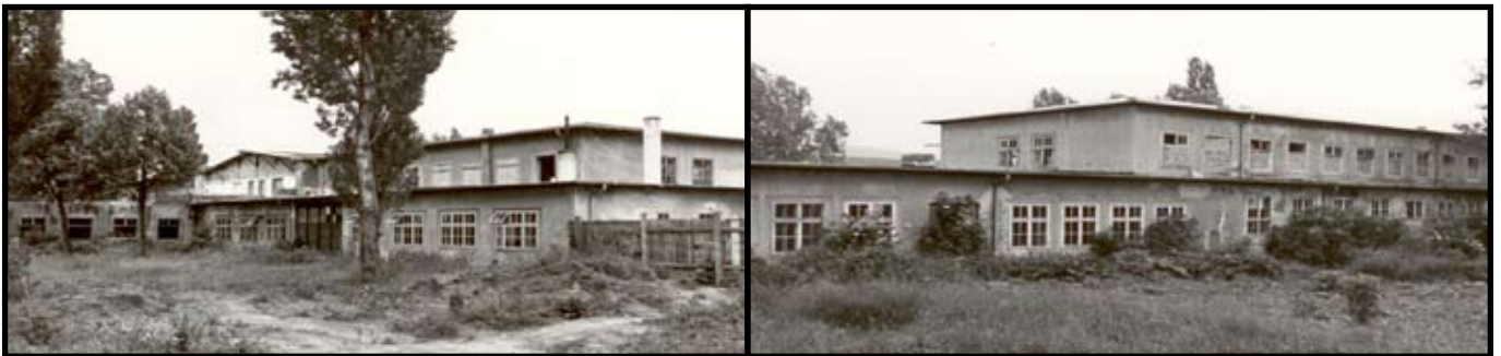
Nach dem Abzug der Sowjettruppen blieben nur noch Ruinen
