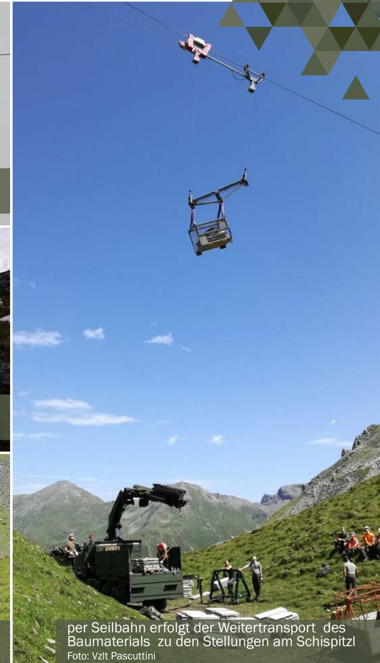
per Seilbahn erfolgt der Weitertransport des Baumaterials zu den Stellungen am Schispitzl
