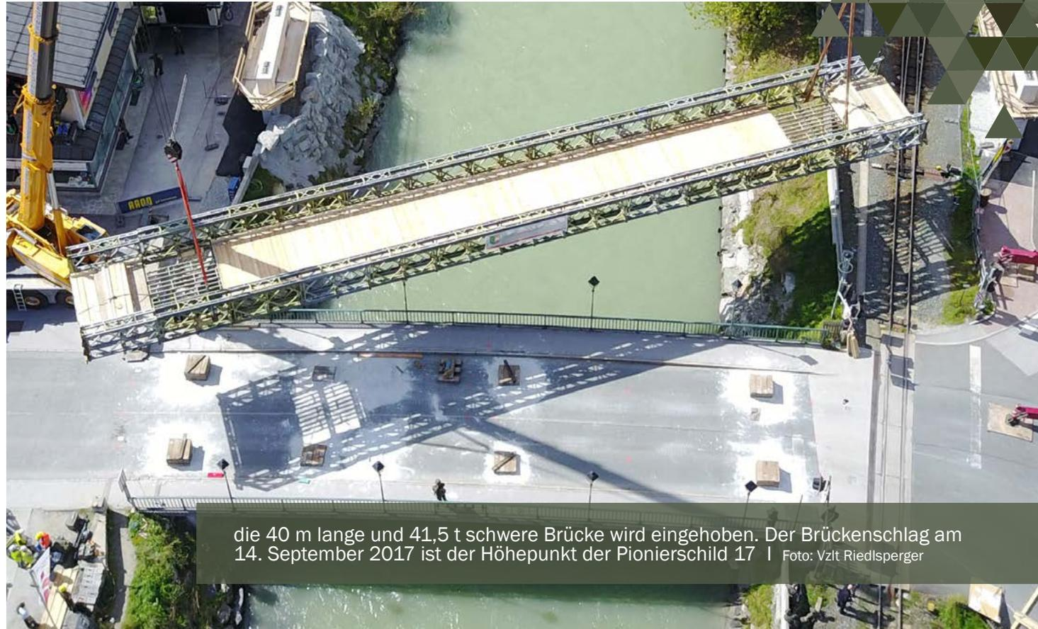
die 40 m lange und 41,5 t schwere Brücke wird eingehoben. Der Brückenschlag am 14. September 2017 ist der Höhepunkt der Pionierschild 17 | Foto: Vzlt Riedlsperger
