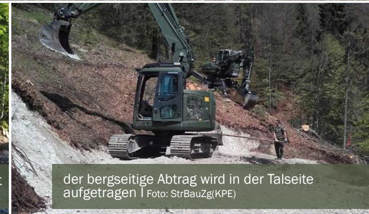
der bergseitige Abtrag wird in der Talseite aufgetragen | Foto: StrBauZg(KPE)
