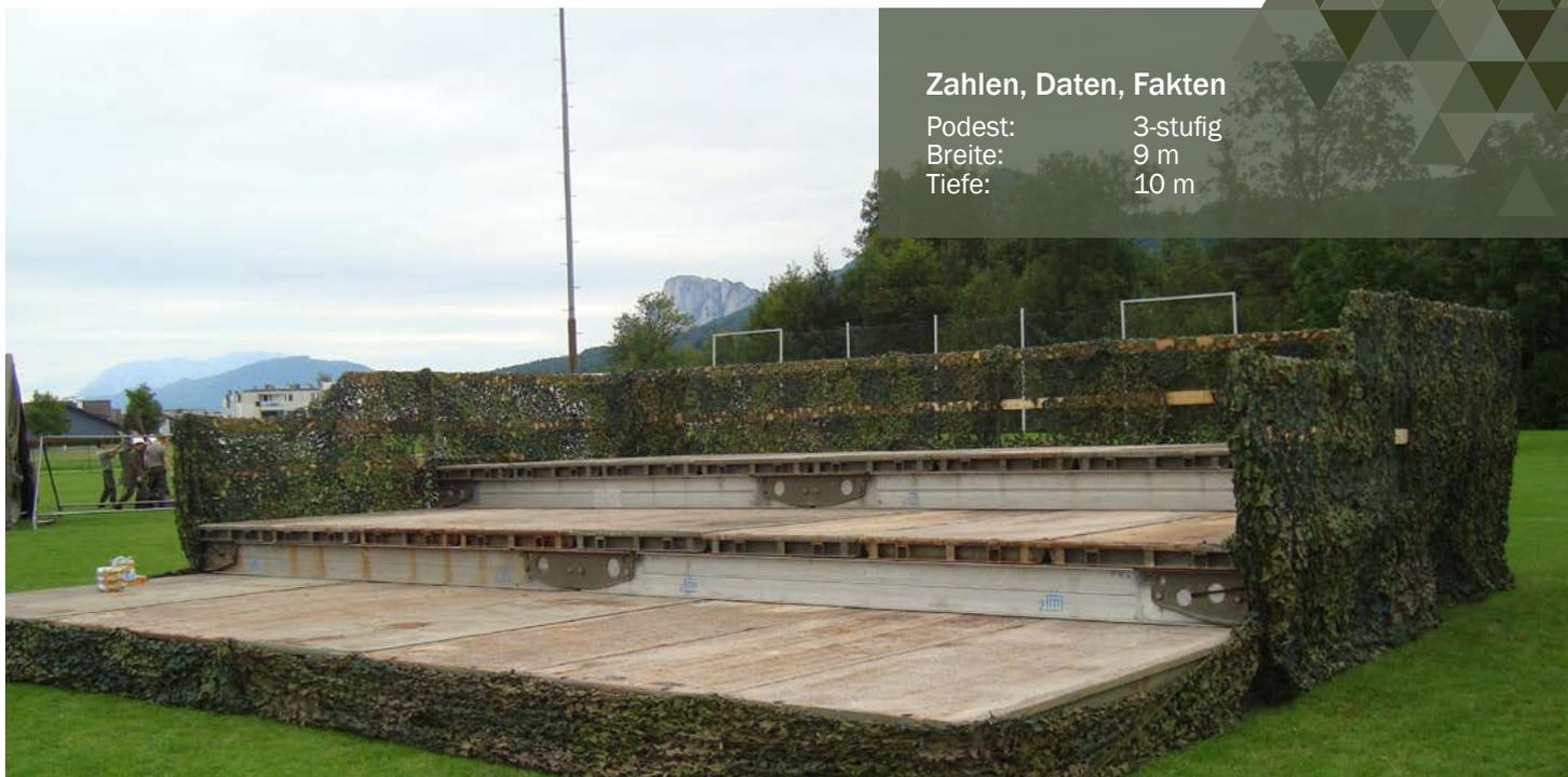
das dreistufige Podest aus Alu-Brückenhauptträgern und D-Brückenfahrbahnplatten
