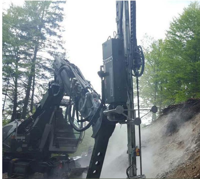
mit der Bohrlafette bohrt der Schreitbagger die Löcher für die Sprengladungen
