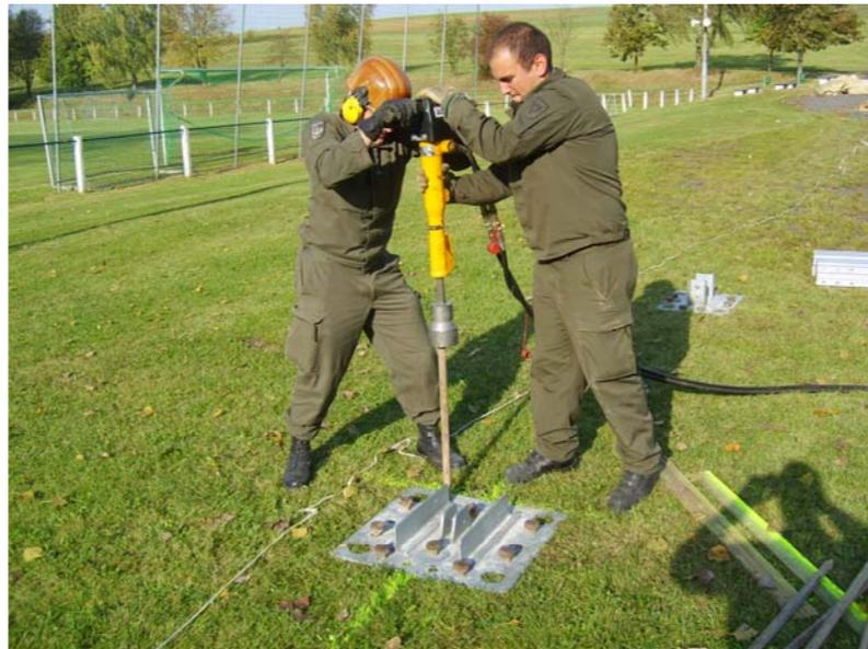
Schlagen der Erdnägeln für die Ankerplatten
