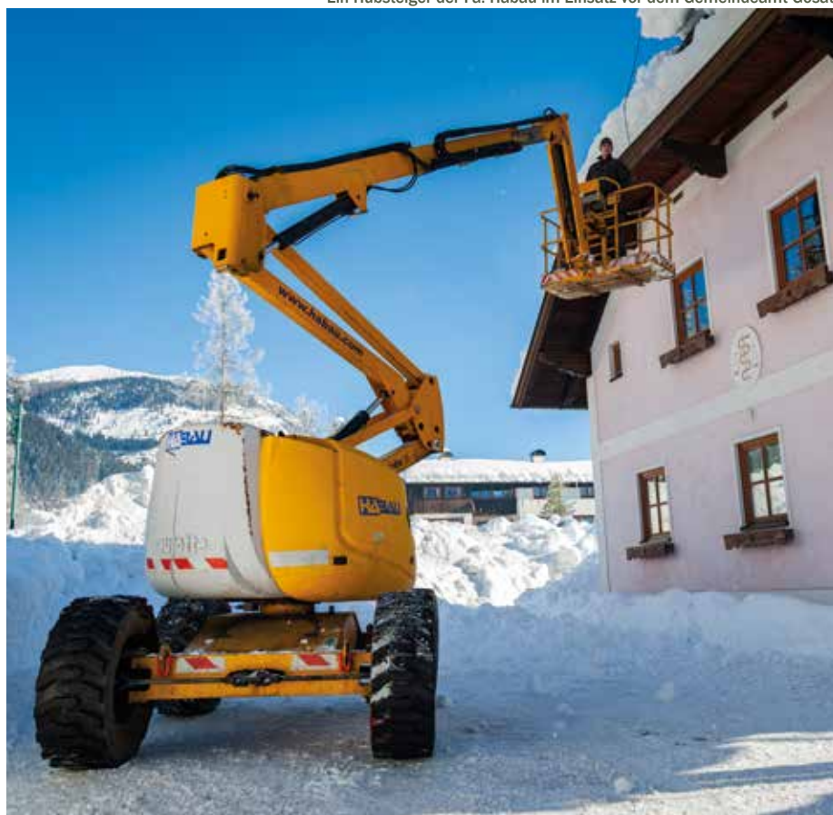
Ein Hubsteiger der Fa. Habau im Einsatz vor dem Gemeindeamt Gosau
