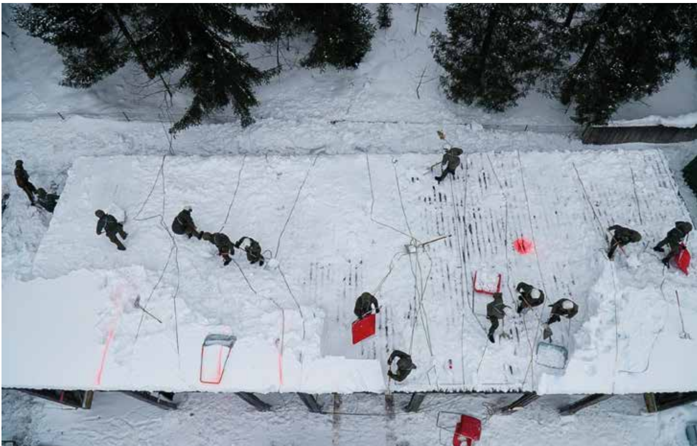
13er im Einsatz auf dem Dach des Altstoffsammelzentrums in Windischgarsten
